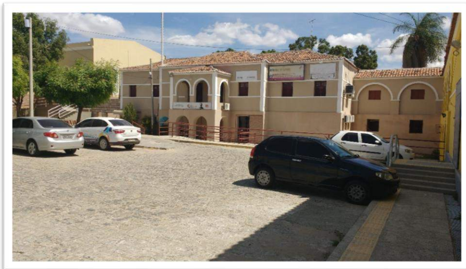
Foto 1: Fachada e Estacionamento
