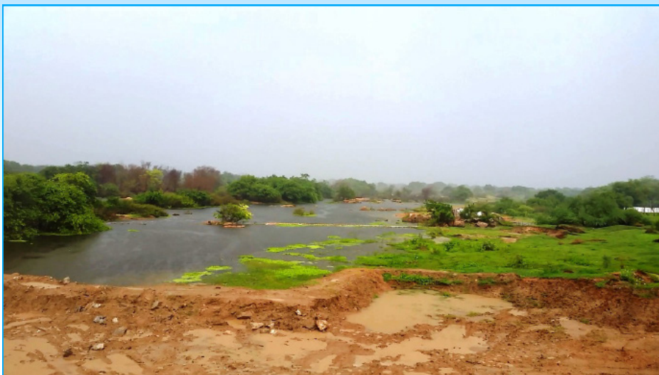
Trecho do rio em Jardim de Piranhas/RN, local aonde acontece a captação de água da Caern
