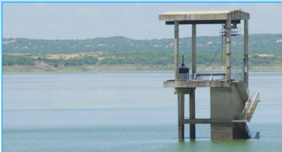
Barragem Armando Ribeiro Gonçalves, em Assú/RN
