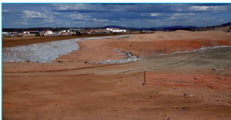
Construção da Barragem de Oiticica em Jucurutu
