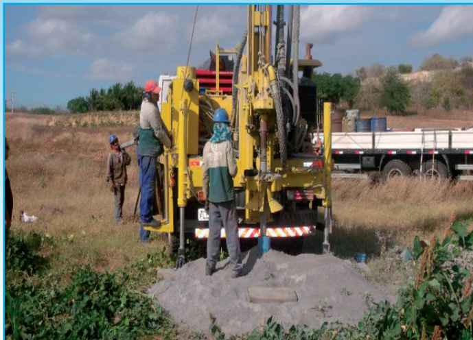
Máquinas trabalhando na escavação de poços tubulares da zona rural de Jardim do Seridó
