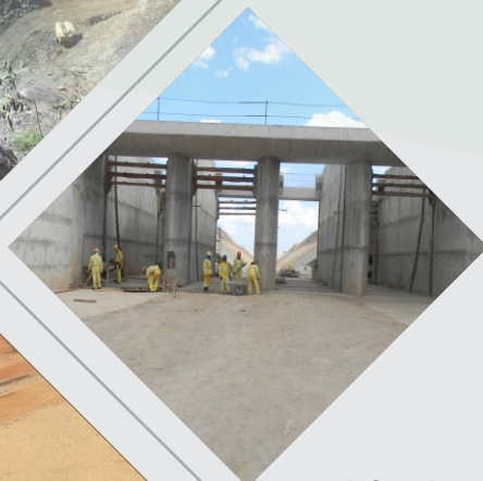
Estrutura de Controle Reservatório Boi I
