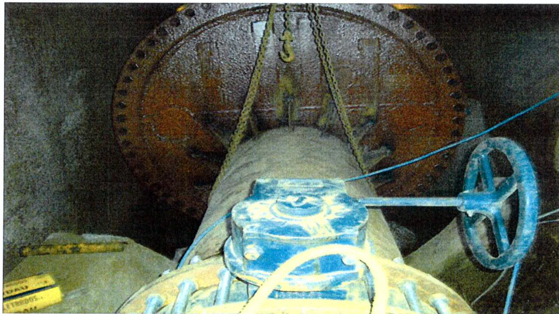
Instalação da válvula borboleta de 800 mm na tubulação da tampa cega.
