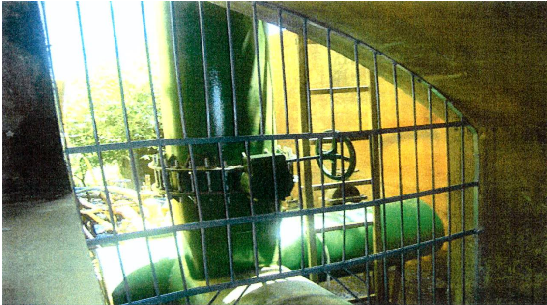
Vista pelo lado de dentro da galeria da derivação e barrilete.
