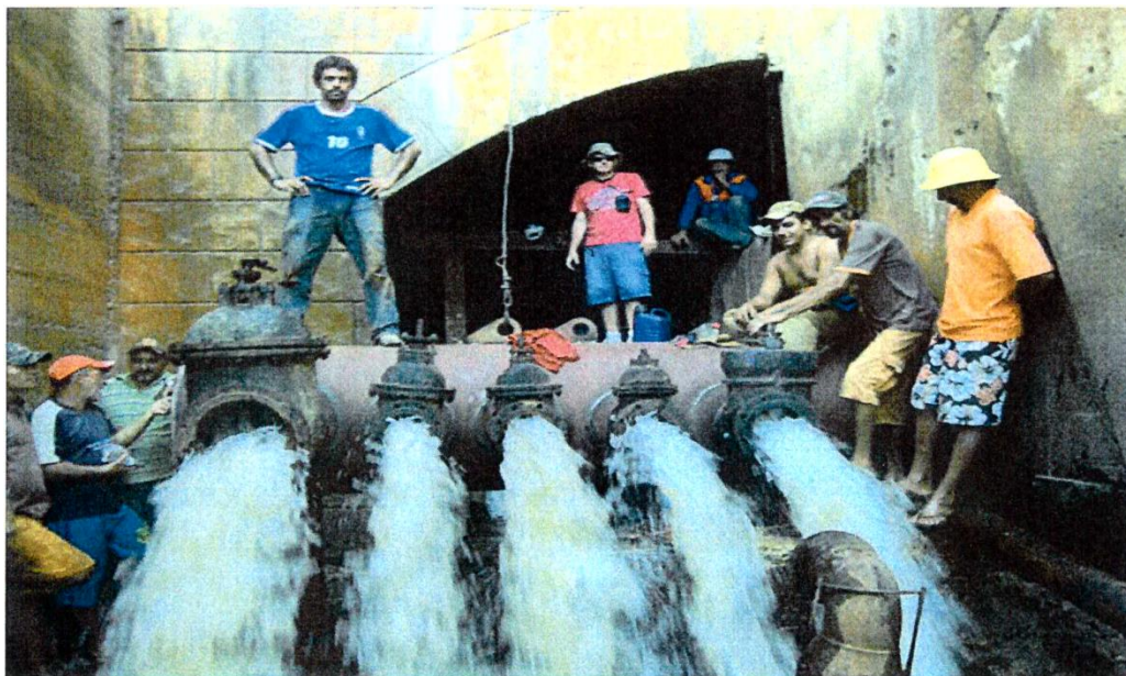
Barrilete em fase de teste.
