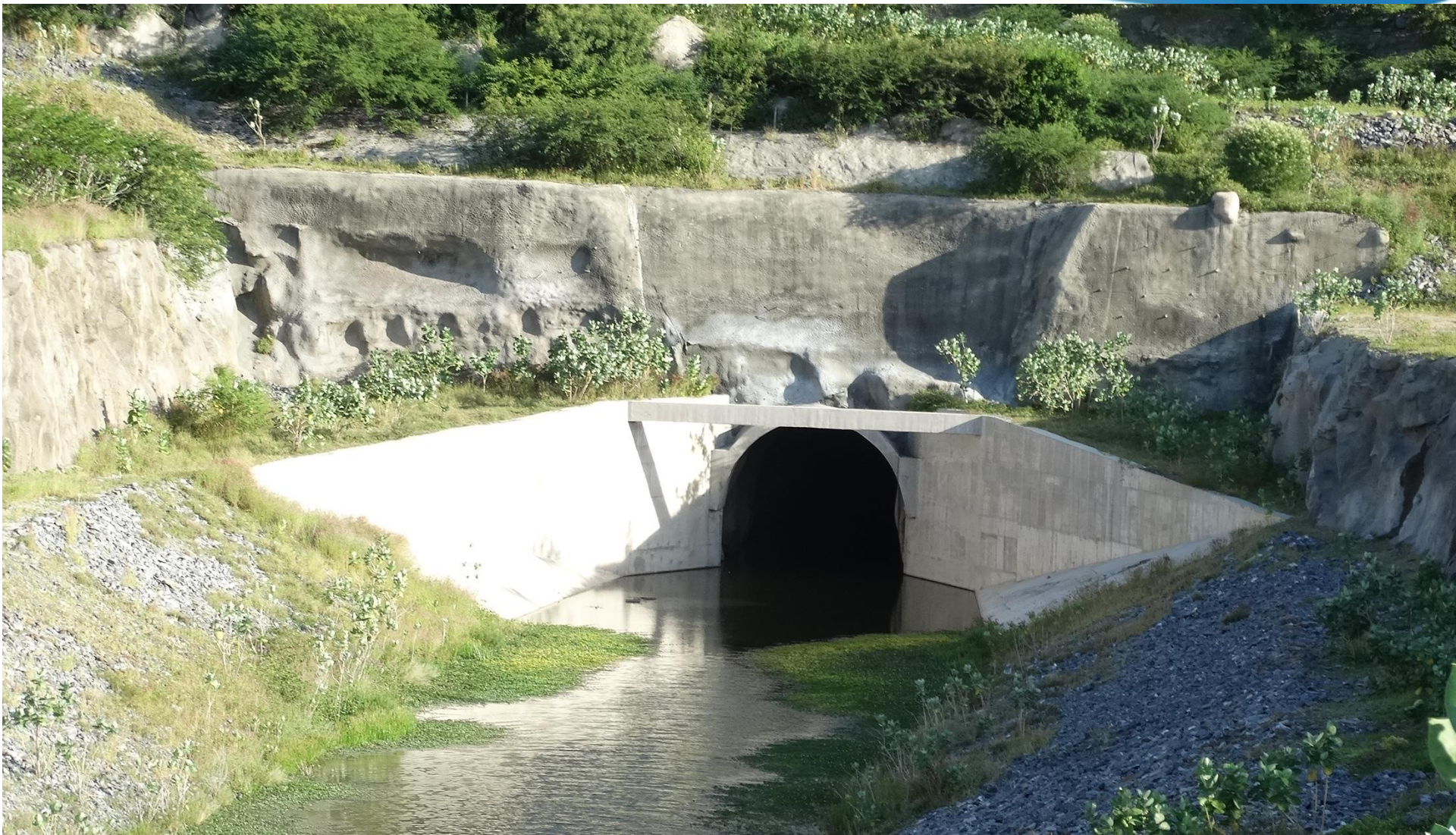
Foto 15: Eixo Norte - Emboque – Túnel Cuncas I
