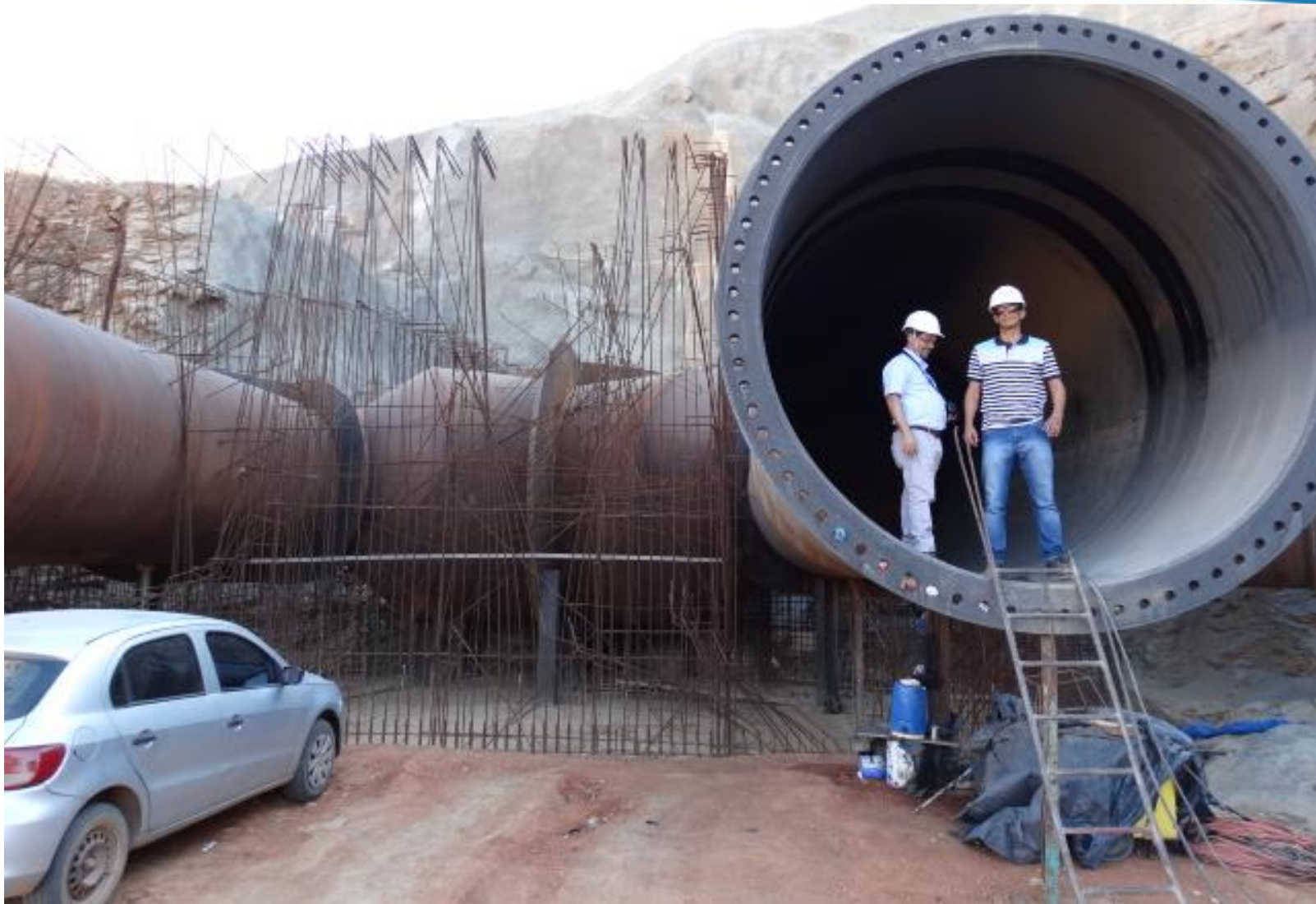
Foto 14: Eixo Norte - Reservatório Atalho - PCH
