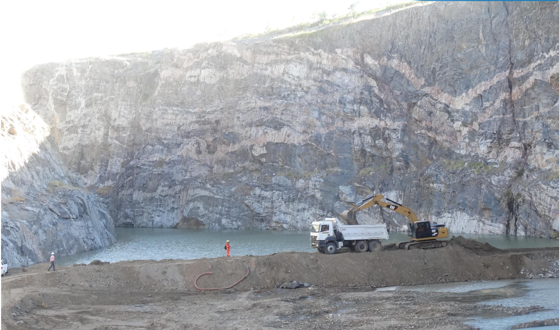
Foto 9: Eixo Norte – Canal de Aproximação – EBI - 3
