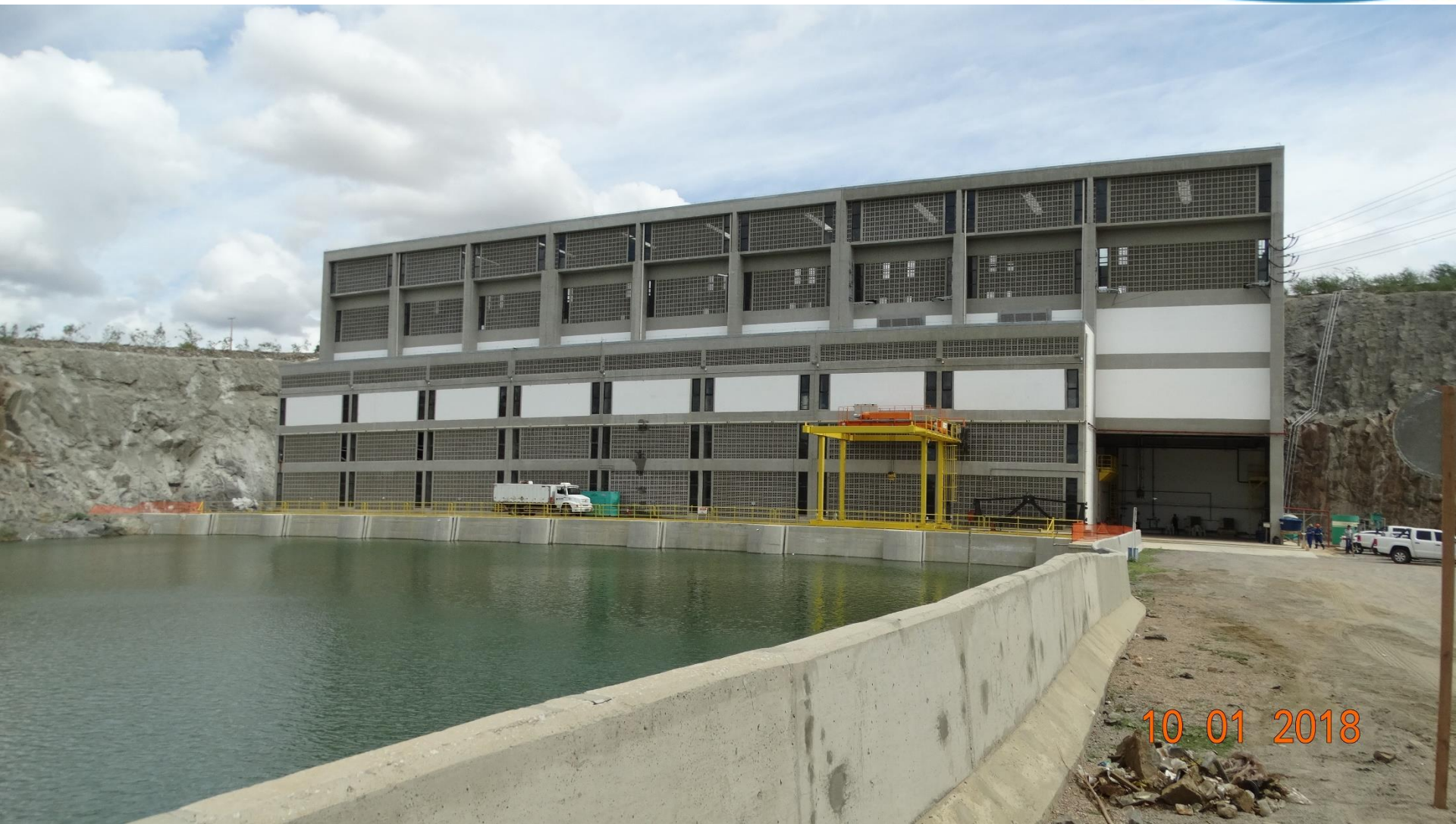
Foto 6: Eixo Norte – EBI-2 - Fachada Principal
