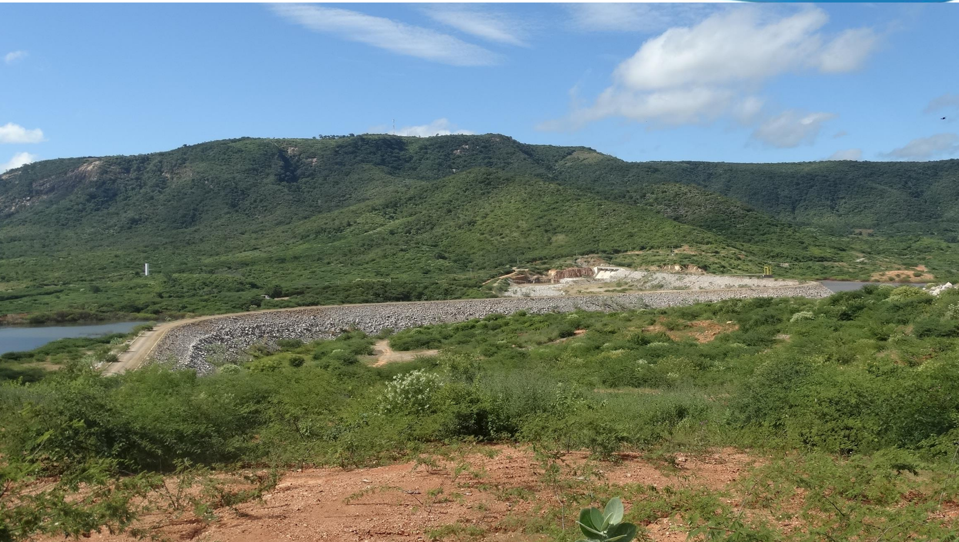
Foto 16: Eixo Norte - Reservatório Caiçara
