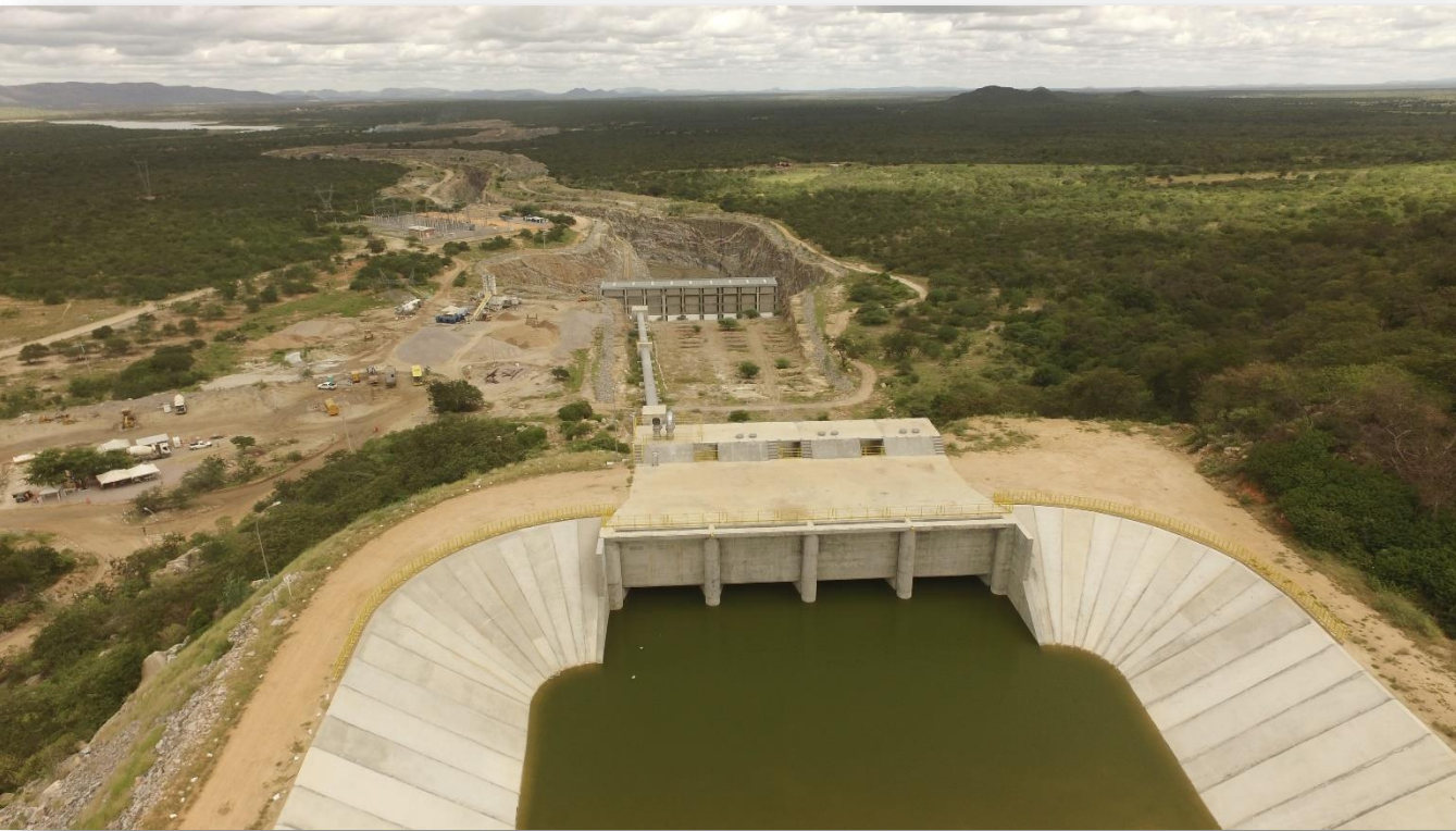
EBI-3: forebay de jusante
