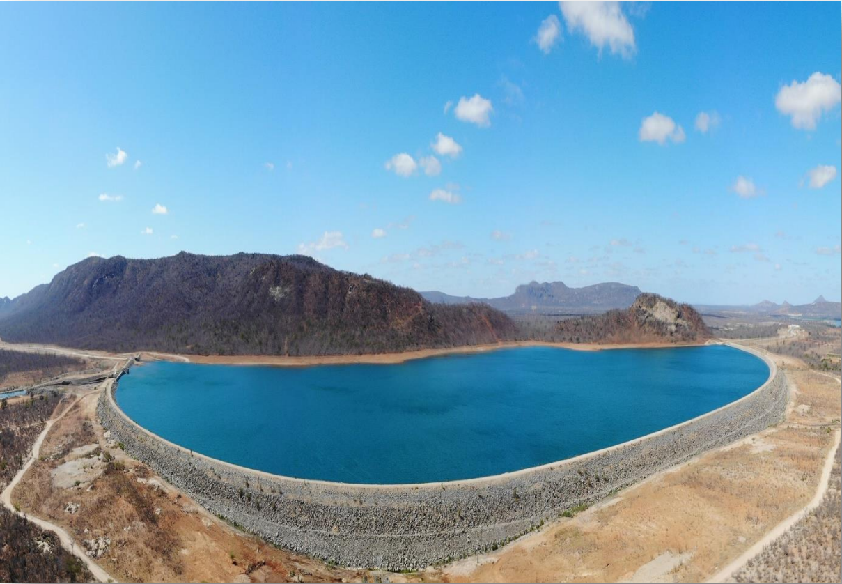
Reservatório Serra do Livramento
