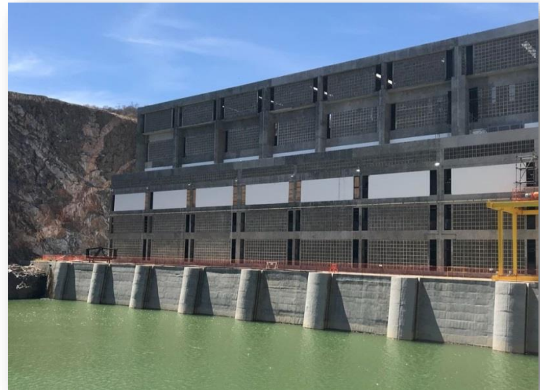
EBI-3 : forebay de montante
