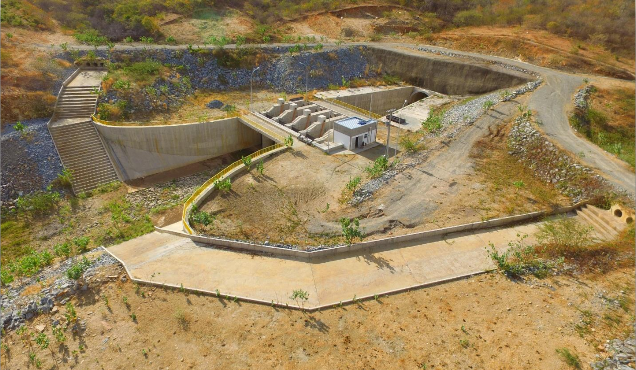
Emboque do Túnel Cuncas II
