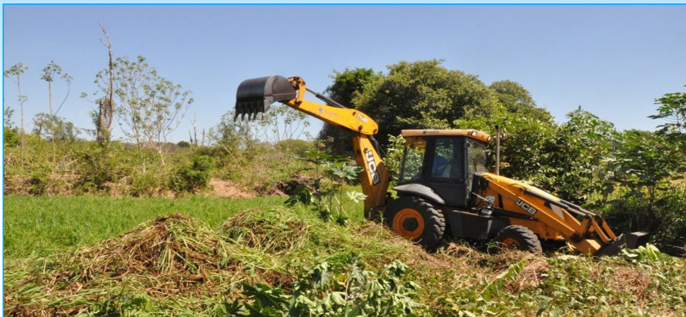
Foto mostra a retroescavadeira que trabalhou na limpeza da calha do Rio Piancó-Piranhas- foto: assecom CBH PPA
