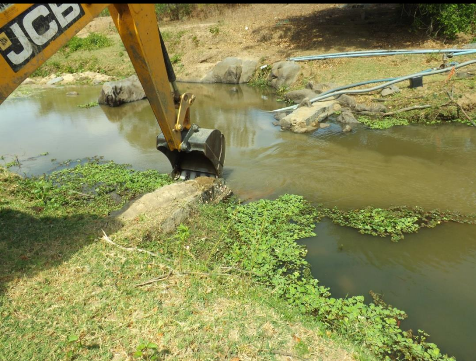
Figura 18: Retirada de barramento de pedra do rio Condado-Conceição PB.
