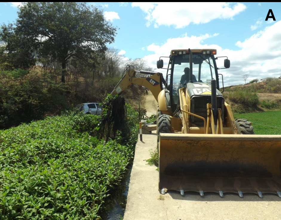
Figura 2: Excesso de vegetação a montante da passagem molhada localizada na comunidade boa vista. (A) antes da limpeza, (B) após a limpeza.
