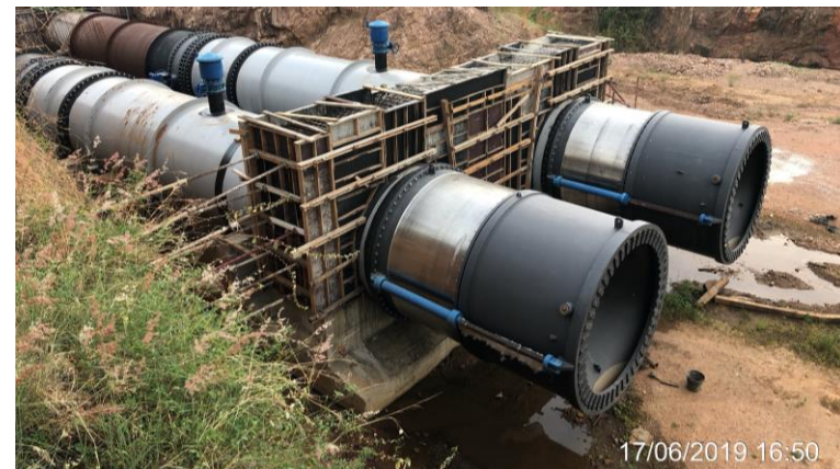
Válvula Dispensora tipo "Howell Burger" DN 2600mm
