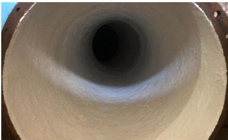
Limpeza e pintura dos tubos de aerção
