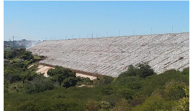
Enrocamento – Talude de jusante
