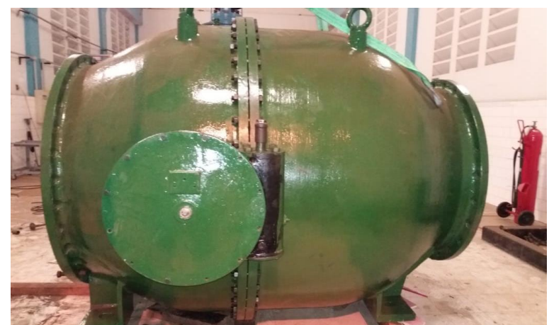
Recuperação da Válvula Anular
