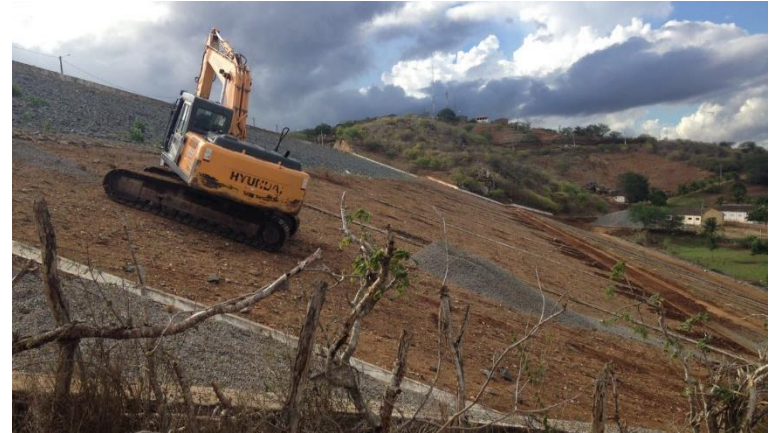
Recuperação do talude de jusante
