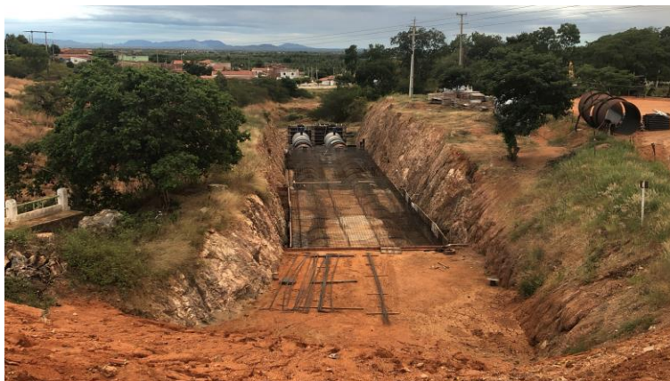
Vista geral - Tomada D'água Suplementar (Jusante)
