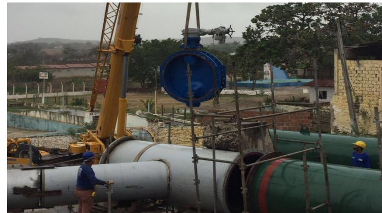
Montagem da válvulas borboleta
