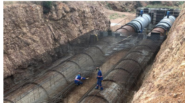
Aplicação de aço CA-50 no bloco de envelopamento da TMDS
