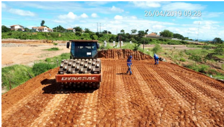
Reconstrução do Dique Auxiliar (concluído)
