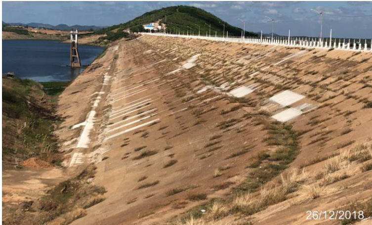
Recuperação das placas de concreto – Talude de Montante
