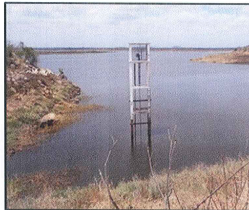
Figura 3 – Estrutura de controle da vazão defluente
