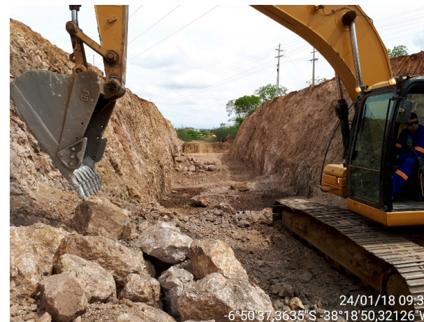
Escavação no local da TMDS
