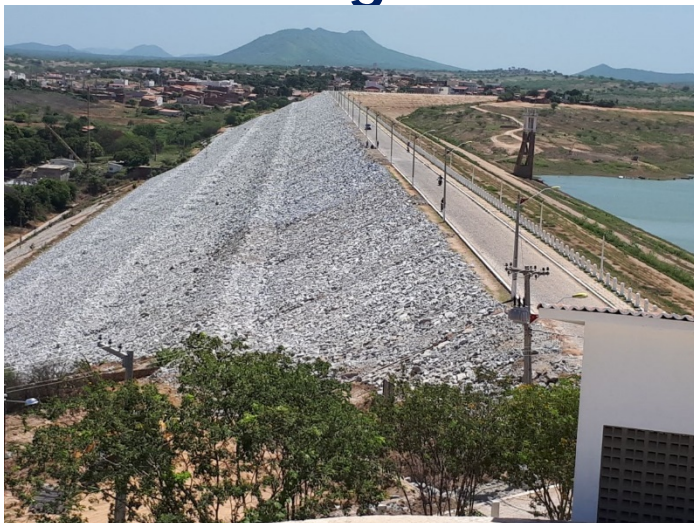
Talude de jusante – enrocamento
