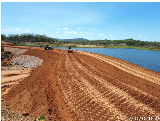
Ensecadeira para execução da TMDS
