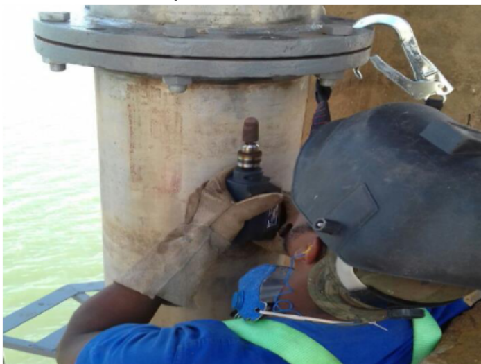
Limpeza e pintura dos tubos de aerção
