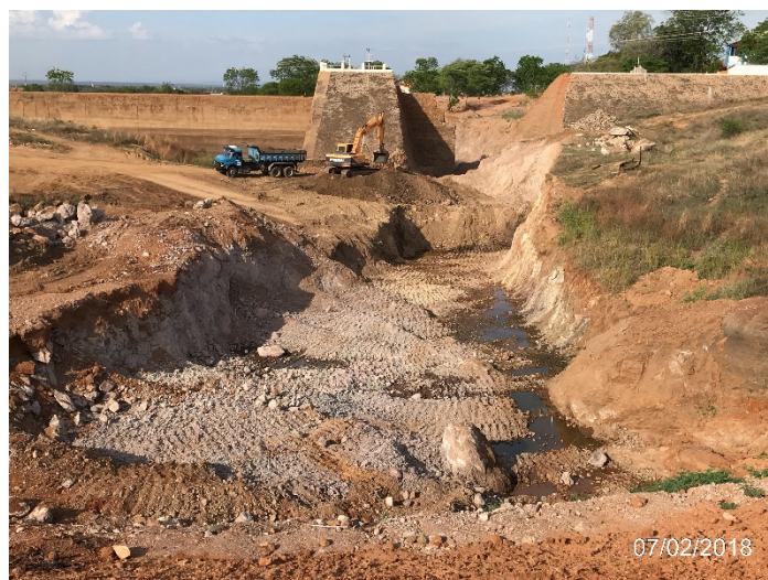
Escavação no local da nova torre de tomada d'água
