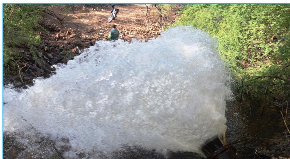
Imagem mostra o momento da abertura da comporta da barragem Carnaúba
