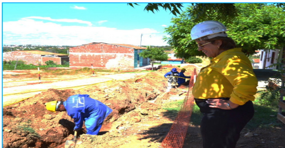
Rosalba Ciarlini em visita às obras de saneamento em Caicó/RN
