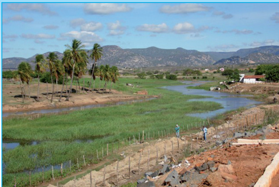
Sistema de Abastecimento de Água em Jucurutu está comprometido
