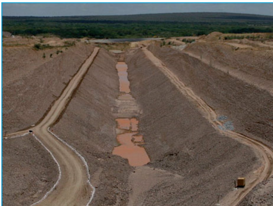
Trecho da obra da transposição do rio São Francisco em São José de Piranhas/PB
