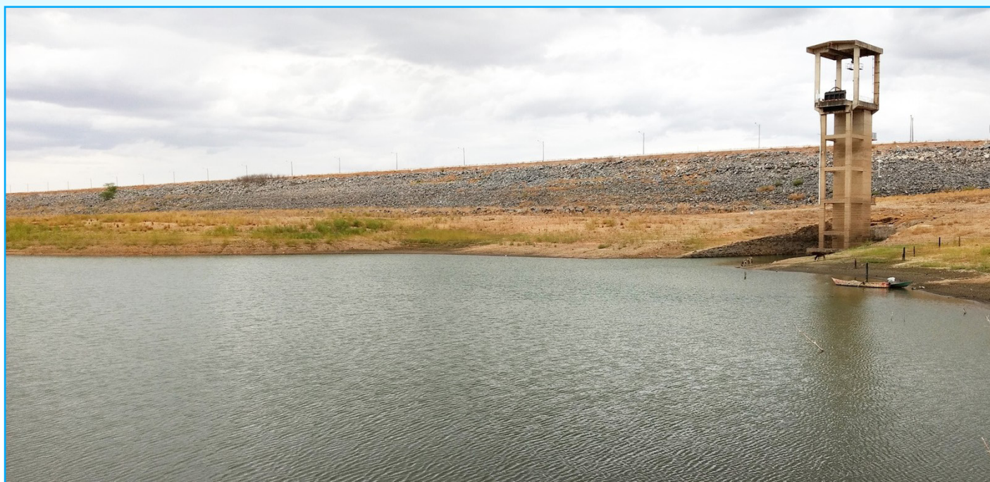
Barragem Armando Ribeiro Gonçalves, no Rio Grande do Norte, é um dos principais reservatórios do estado
