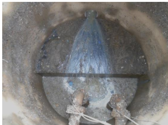
Poço de sucção para encaminhamento do esgoto à ETE 02
