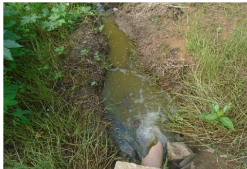
Saída do efluente tratado
