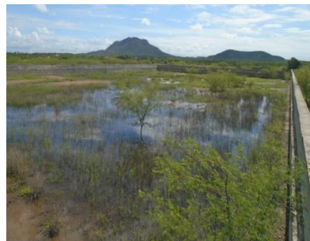
Vista geral da Lagoa Facultativa (F)
