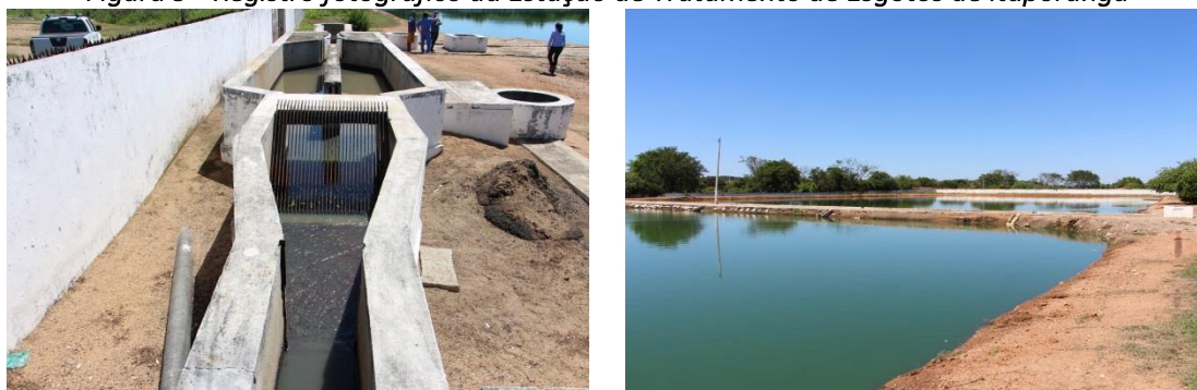
Figura 9 - Registro fotográfico da Estação de Tratamento de Esgotos de Itaporanga
