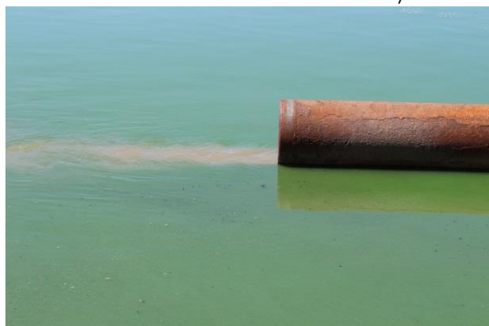
Detalhe para a coloração esverdeada do esgoto nas lagoas de estabilização
