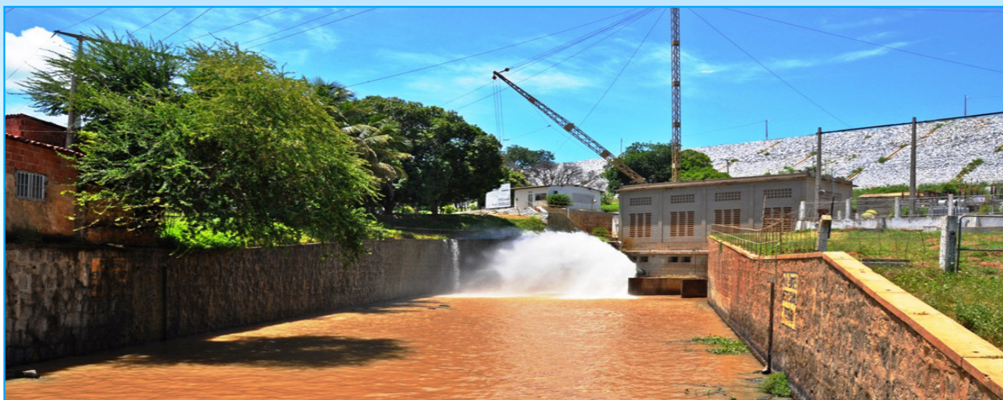
A imagem mostra a saída de água do açude Curemas/PB que segue pelo rio Piranhas até o Rio Grande do Norte - Foto: Assecom CBH PPA
