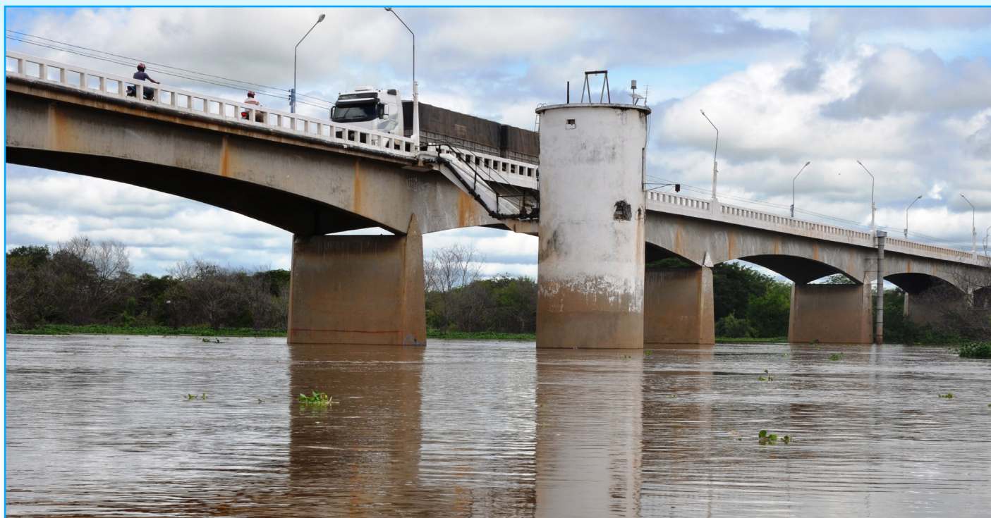
Ponte sobre o rio Piranhas, em Jardim de Piranhas, com o nível elevado após as chuvas caídas no mês de abril - Foto: Assecom CBH PPA
