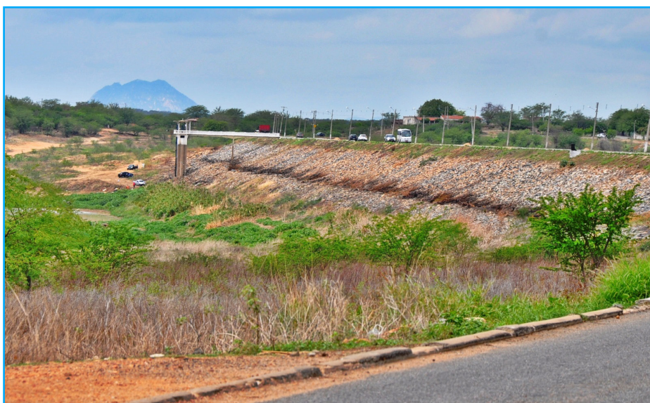
Parede do açude Itans após recuperação do DNOCS - Foto: Assecom CBH PPA
