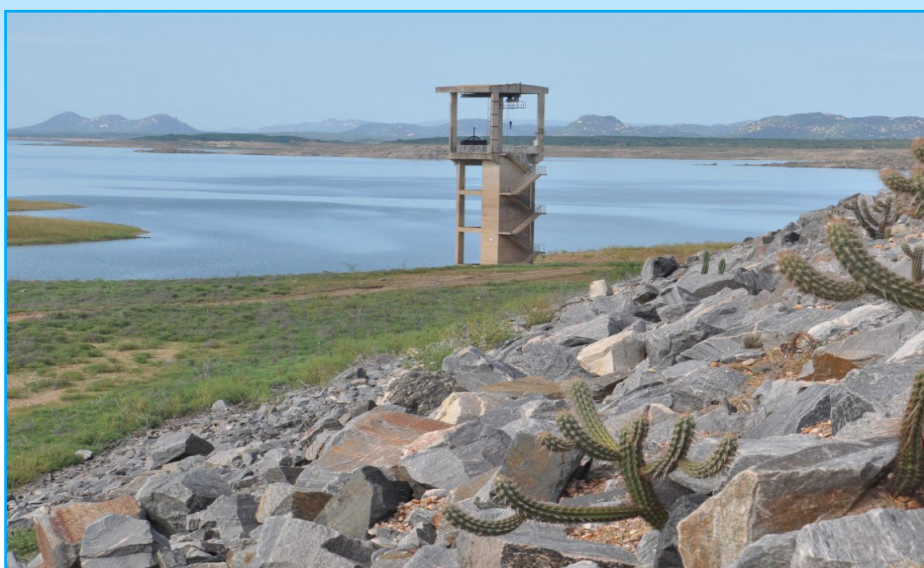
Parede da Barragem Armando em reforma- Foto: Assecom CBH PPA
