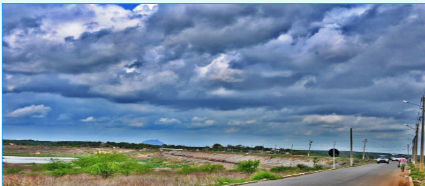
Imagem mostra a parede do açude Itans, em Caicó, com as nuvens carregadas em dia de chuva - Foto Geraldo Oliveira
