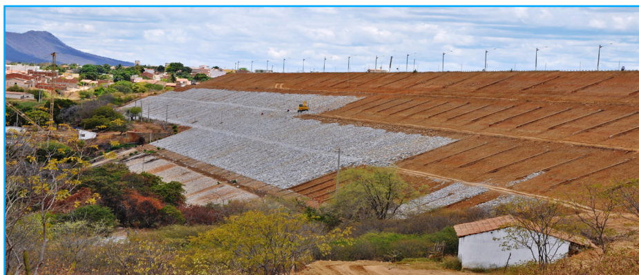
Parede do Açude Curemas em obras preparatórias para o PISF - Foto: Assecom CBH PPA
